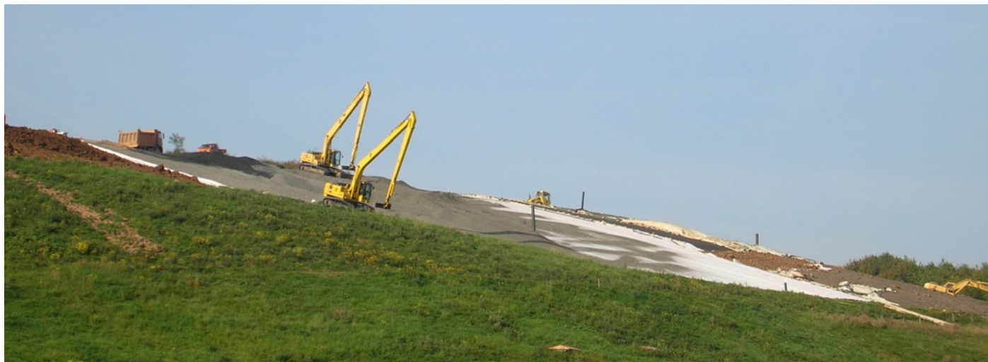
Abb. 2: Aufbringung der Oberflächenabdichtung auf den Deponieabschnitt BA3
