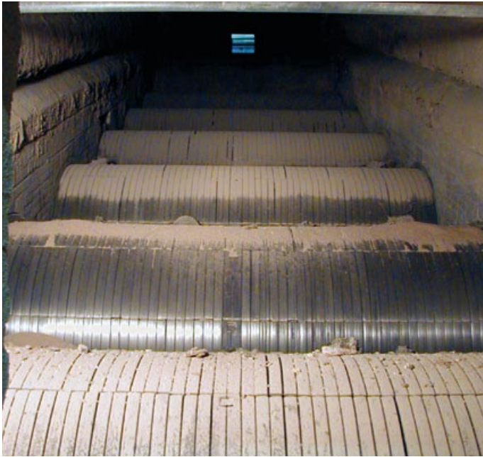
Abb. 2: Walzenrost einer Verbrennungslinie bei Revisionsarbeiten
